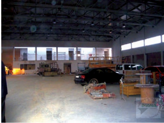
Las obras estaban en este punto en Diciembre de 2009
