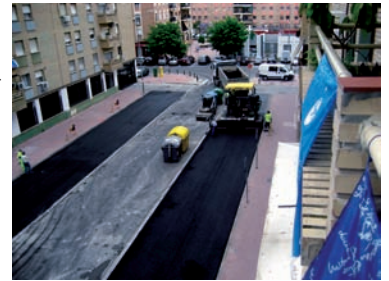
Asfaltado de la calle Neptuno y calle Mercurio
