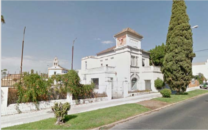
Edificio " la Torre", 1926
