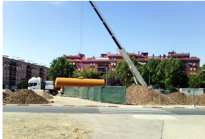
Inicio Obras de la Gasolinera
